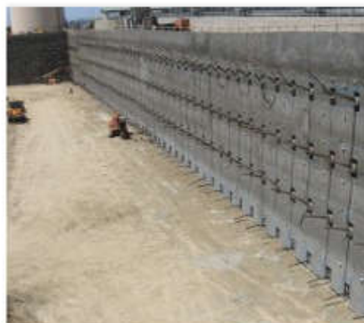
اجرای نیلینگ و انکراژ
