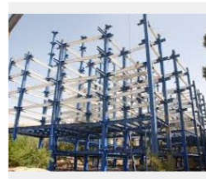
اجرای اسکلت فلزی
