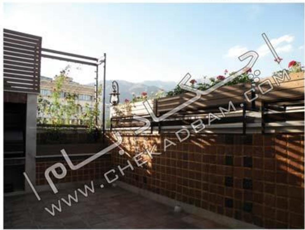
اجرای فلورباکس پشتبند دار چوب پلاست جهت کاهش دید به تراس WWW.CHEKADBAM.COM
