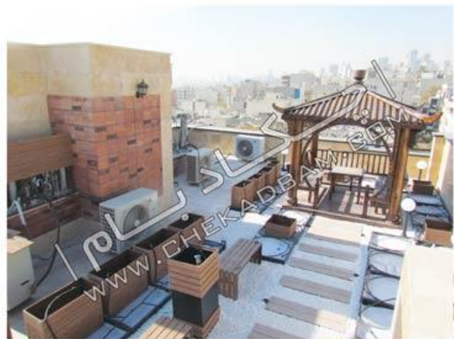
اجرای روف گاردن به روش پرتابل-مدولار ( قبل از مرحله کاشت ) تهران - بلوار کاوه - سال ۱۳۹۵
