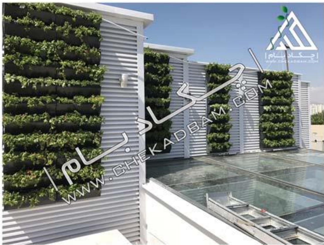
پوشش بخش تاسیسات در پشت نام استفاده از دیوار سبز مدولار
